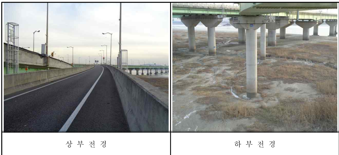
【이산포IC RAMP-H교 전경】
