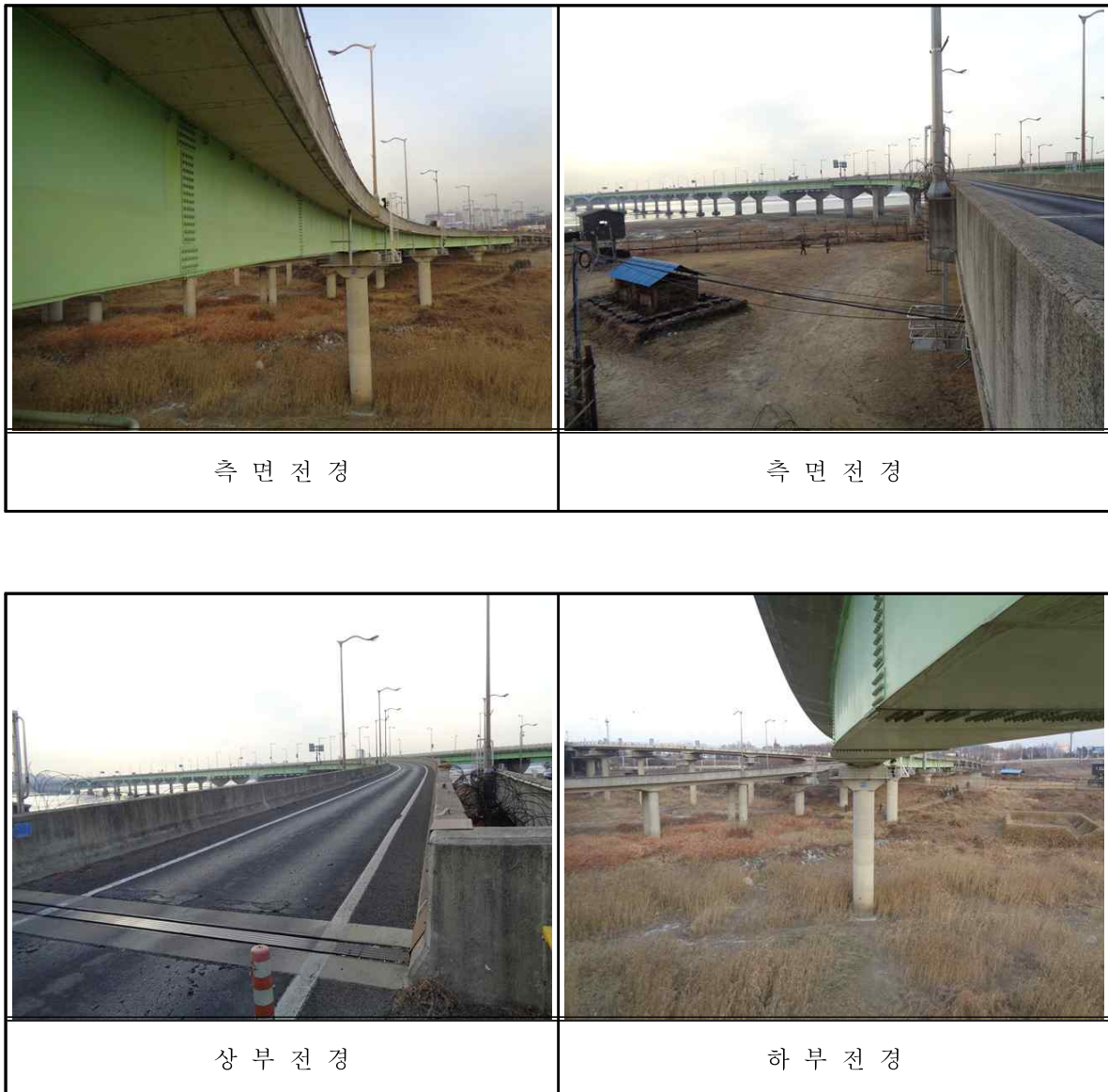
【이산포IC RAMP-G교 전경】
